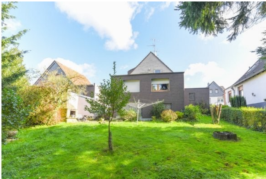
Anbau im Unter- und Erdgeschoss
