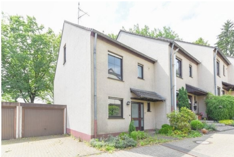
Außenansicht der Immobilie
